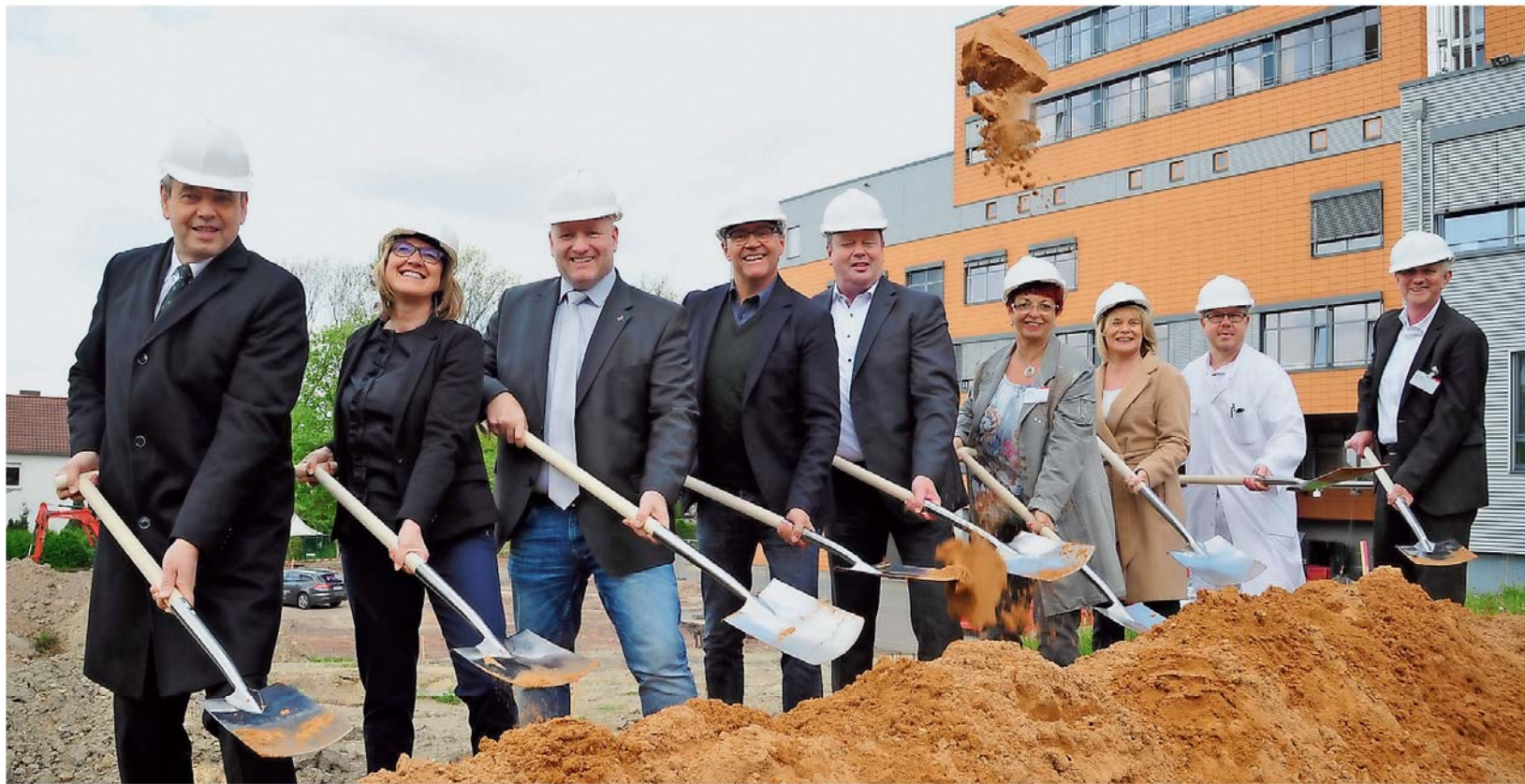
Beim Spatenstich zum Neubau der Intensivstationen (von links): Michael Ludes (Architekt), Marianne Thömes (SHG-Baudirektorin), Christof Sellen (Bürgermeister von Völklingen), Peter Gillo (SHG-Aufsichtsratsvorsitzender), Bernd Mege (Geschäftsführer der SHG), Monika Klein (Pflegerin), Christiane Blatt (Oberbürgermeisterin von Völklingen), Professor Harald Schäfer (Ärztlicher Direktor) und Edgar Mertens (Verwaltungsdirektor). FOTO: BECKER & BREDEL
