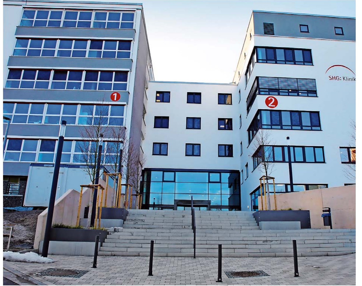
Der sanierte Altbau aus den 1960er-Jahren (links) und der Neubau von 2018 wirken wie eine Einheit. FOTO: HEIKO LEHMANN
