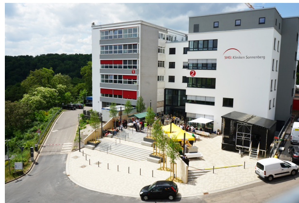
Der vierstöckige Neubau mit großem Foyer, Lichthof und Cafeteria gibt den Kliniken auf dem Sonnenberg ein neues Gesicht.
