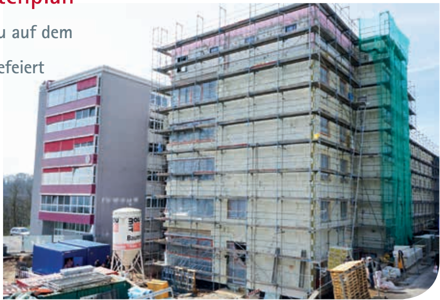
Der Rohbau steht. Jetzt geht es mit der Fassade und der Innenausbau weiter.
