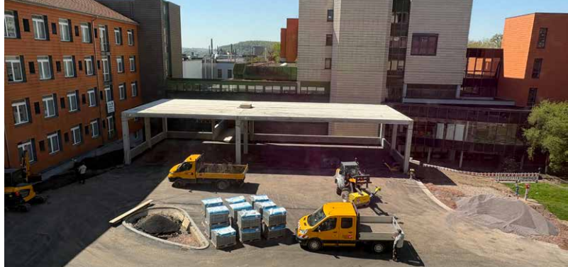
Kernstück der Baumaßnahme: wettergeschützte Aufstellfläche für mehrere Rettungsfahrzeuge.
